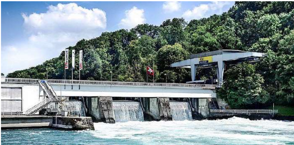
Abb. 148: Das Wasserkraftwerk Schaffhausen liefert die CO 2 -frei-Energie für die E-Busse
