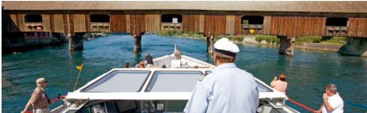
Abb. 50: Kursschiff auf dem Hochrhein vor der Diessenhofener Brücke
