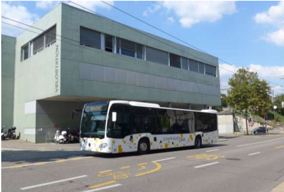
Abb. 119: Velostation am Bahnhof Schaffhausen
