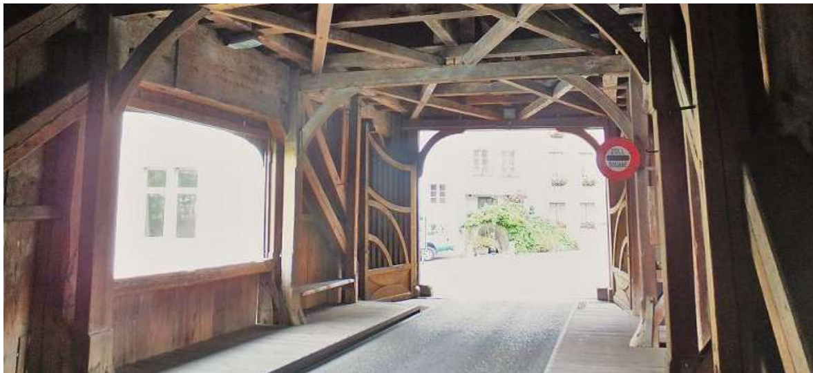
Abb. 80: Rheinbrücke zwischen Diessenhofen und Gailingen (Ausgang Diessenhofen)
