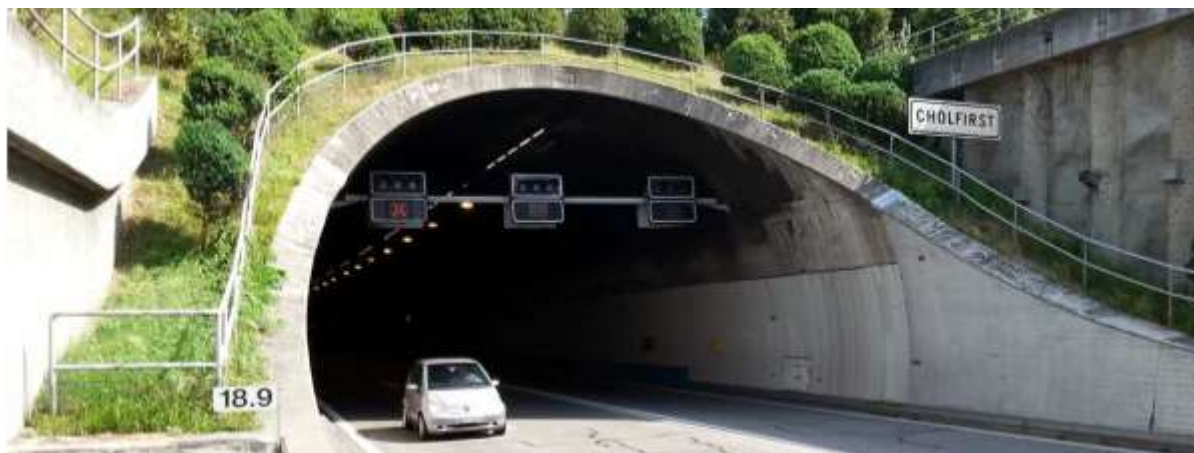
Abb. 77: Südportal des Cholfirsttunnels
