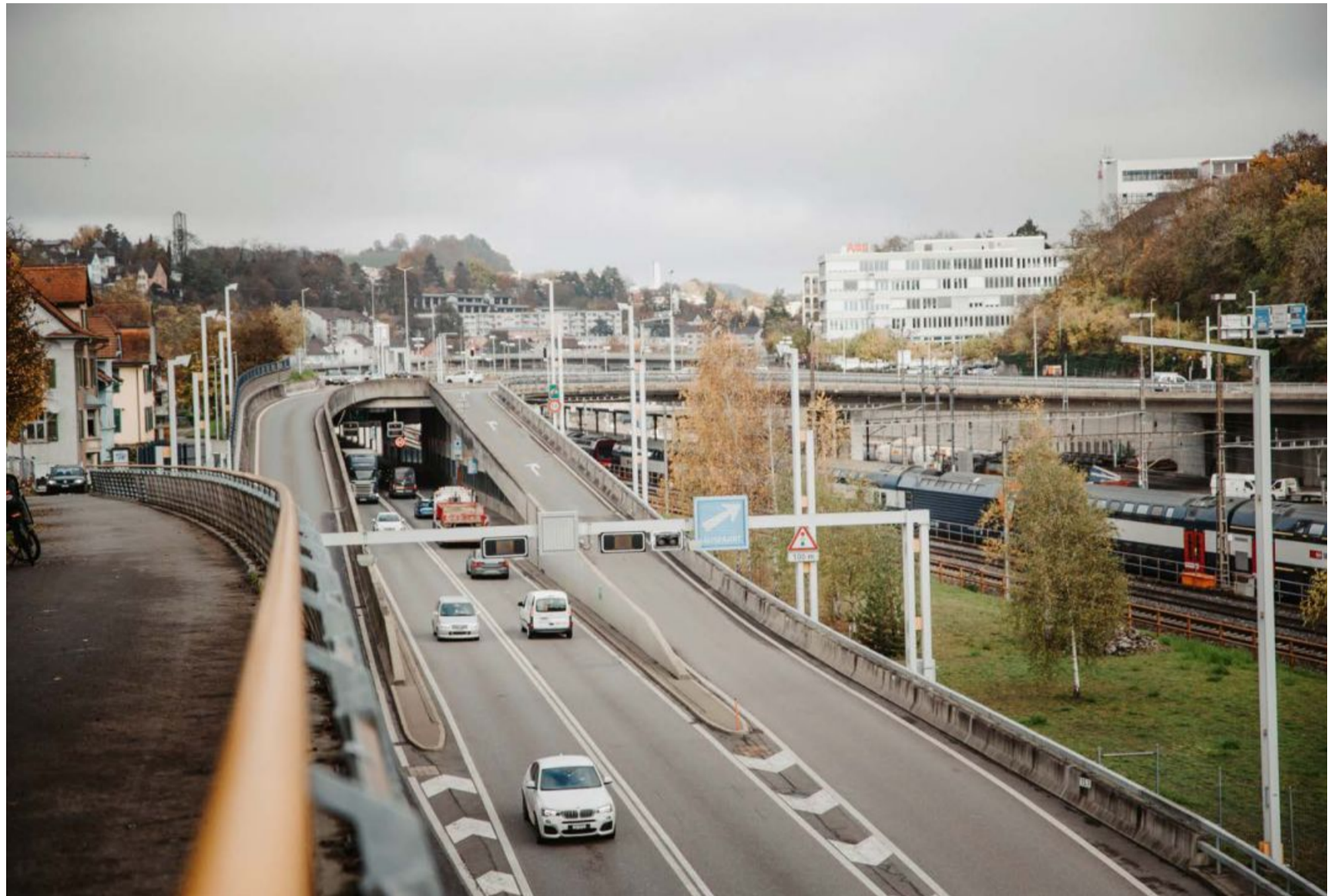
Die Autobahnausfahrt Schaffhausen Nord soll im Rahmen des Fäsenstaubprojekts reduziert werden.
